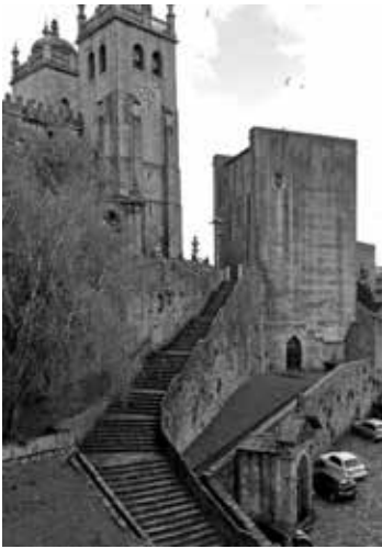
Fig 3 Casa dei Ventiquattro, Porto. Fotografia di Stefano Perego.
